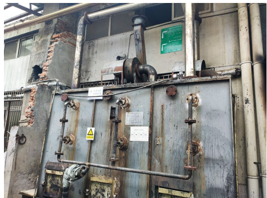
燃烧烟尘湿法除尘器
