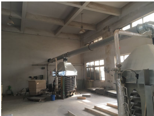
热压工序有机废气集气罩收集
